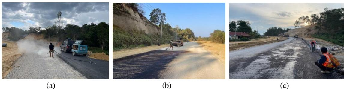
**Gambar 2** (a) Pembersihan Lahan (b) Penyemprotan *Primecoat* (c) Pembuatan *Marking*
