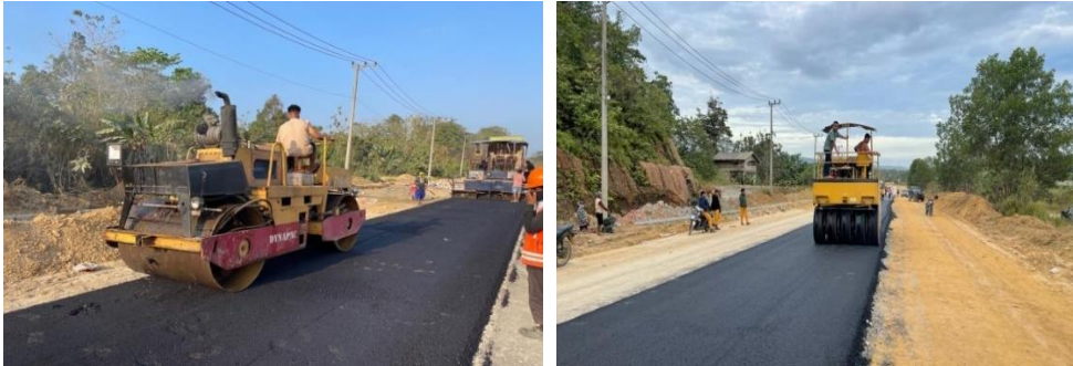
Gambar 2. Percobaan pemadatan lapangan
