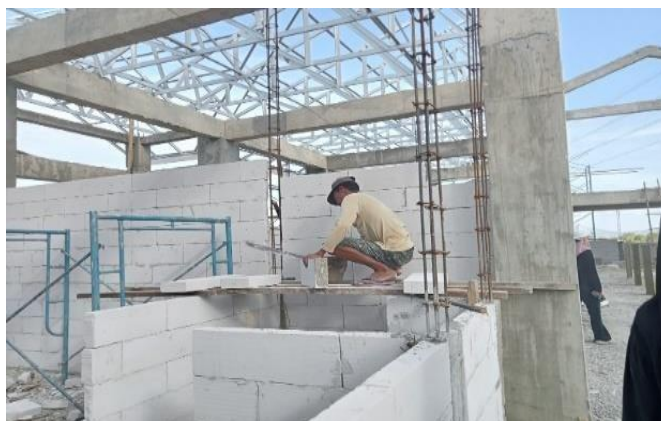
Gambar 2. Proses Pemotongan Bata ringan (Sumber : Dokumentasi Lapangan, 2023)
