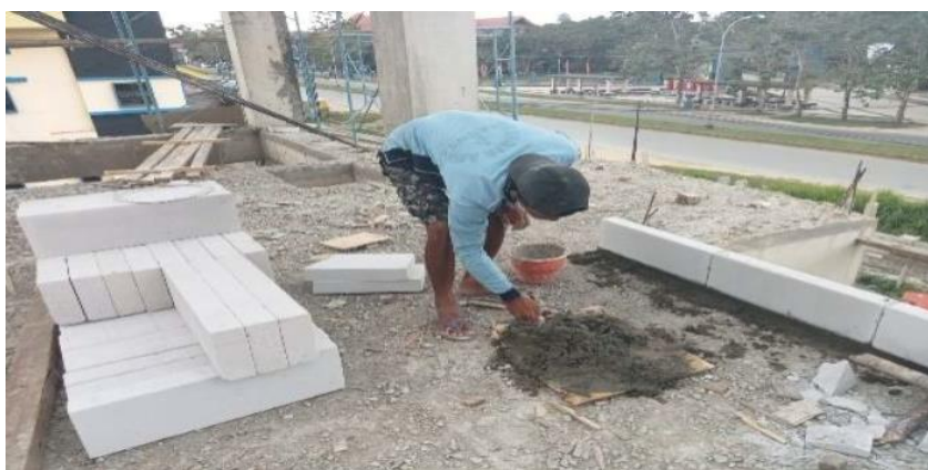
Gambar 1. Proses Pemasangan Bata ringan yang Dikerjakan (Sumber : Dokumentasi Lapangan, 2023)
